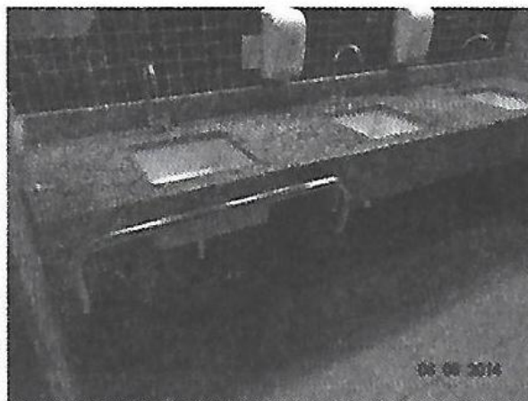
Figura 02. Exemplo de bancada na vistoria de retorno – com barra de apoio. Fonte: Acervo MPRN.
