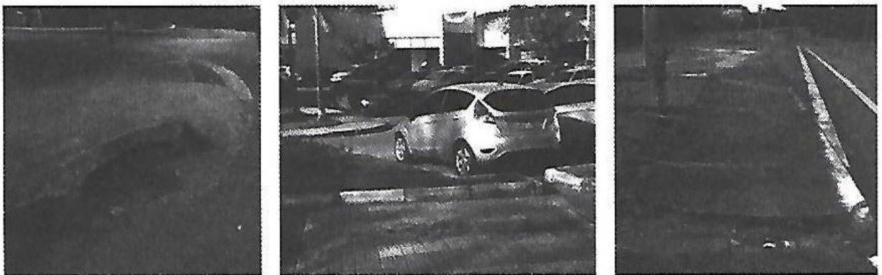
Figura 6 – À esquerda, Rampa fora dos padrões aceitáveis. Ao centro, Faixa de pedestre culminando em um canteiro. À direita, Descontinuidade da pavimentação do piso da calçada. Fonte: LEAUD (2013).
