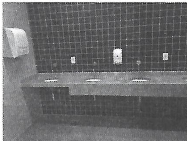
Figura 01. Exemplo de bancada na primeira vistoria – sem barra de apoio. Fonte: Acervo MPRN.
