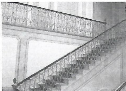
Figura 7 – Revestimento das paredes em escaiola na circulação vertical – escada principal
