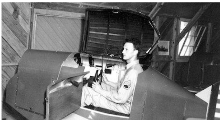
Figura 4. The Link Trainer , o primeiro exemplo de um simulador de voo comercial. Fonte: https://www.vrs.org.uk/virtual-reality/history.html
